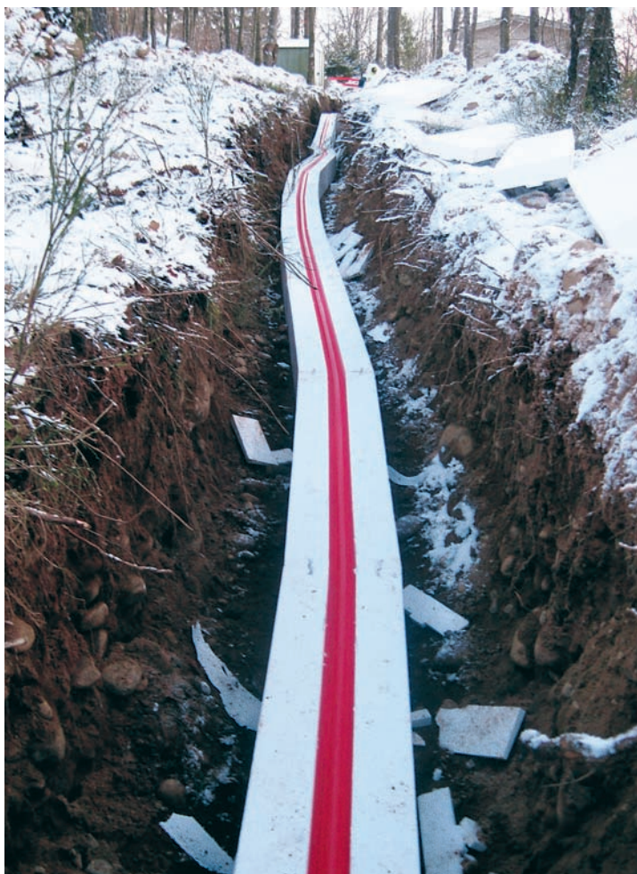
Kulverten är anlagd med företaget Elgocells teknik, vilket gör att värmeförlusterna blir låga.
